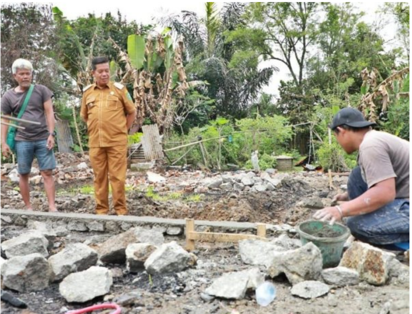
Bupati Simalungun Radiapoh Hasiholan Sinaga saat meninjau pelaksanaan pembangunan ke 7 rumah milik warga
