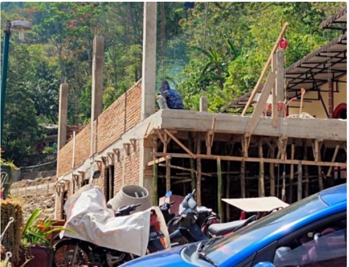
Bangunan Hotel Sedayu di Jalan Bangun Dolok
